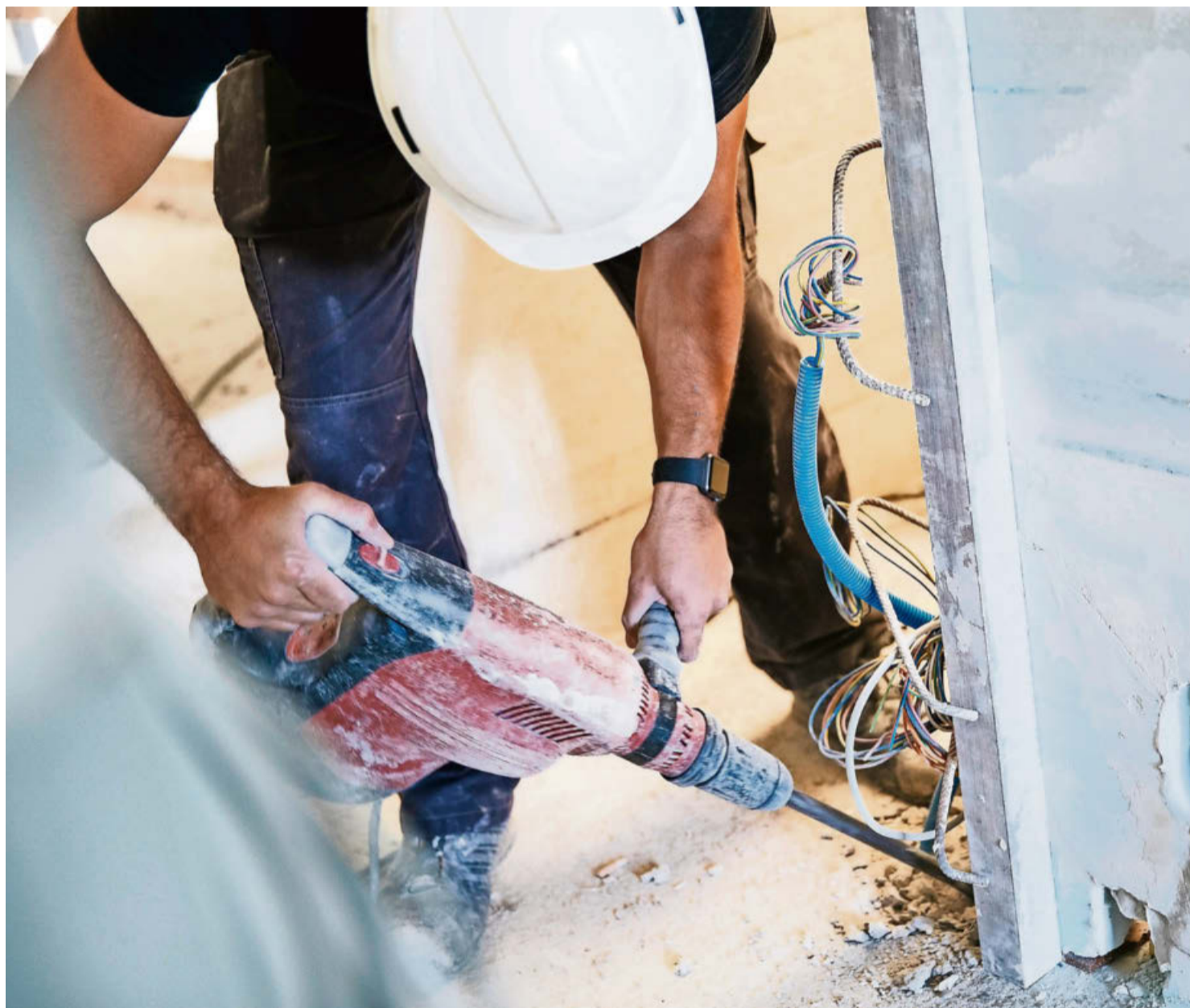
Montage-Elektriker im Einsatz auf der Baustelle.
